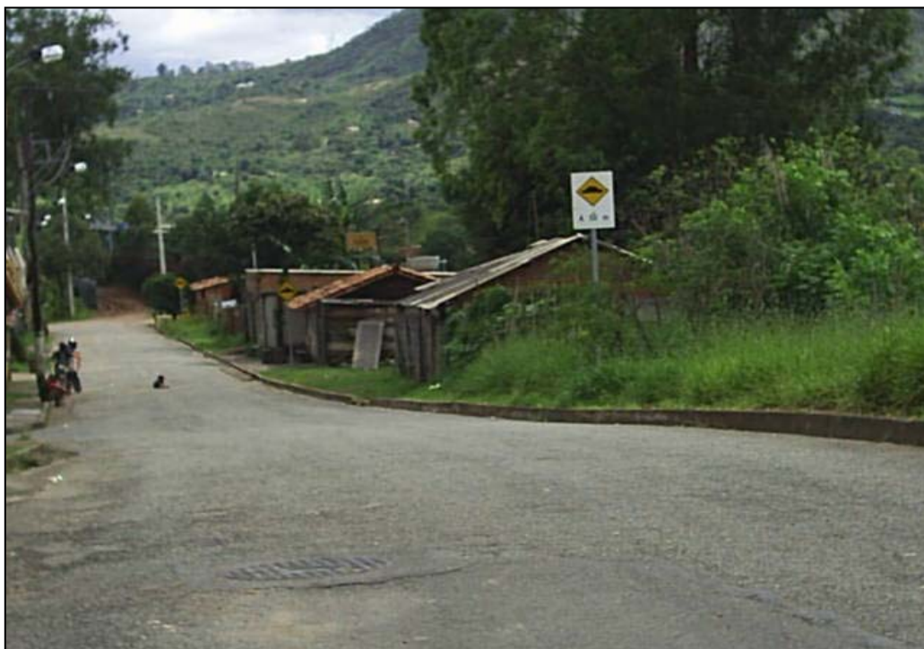
Figura 9 - Invasão da faixa “Non aedificandi” da rodovia-vista da rua paralela à rodovia
