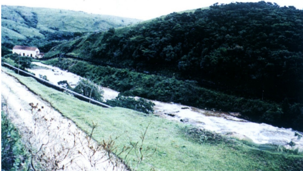
Fig 05: - Rio das Mortes a montante da Usina de Ilhéus
