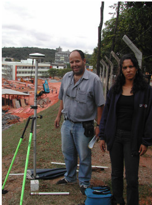
Foto 3.3 - O levantamento de campo com o GPS, no campus da UFMG, no marco topográfico S4. Localizado ao lado da caixa d'água anexa ao prédio do IGC, onde foi instalado o receptor fixo
