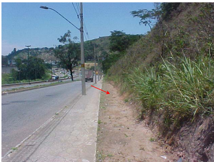
Figura 9 – Trecho do Anel Rodoviário, próxima ao vértice 14, com barranco obstruindo parcialmente a face norte.
