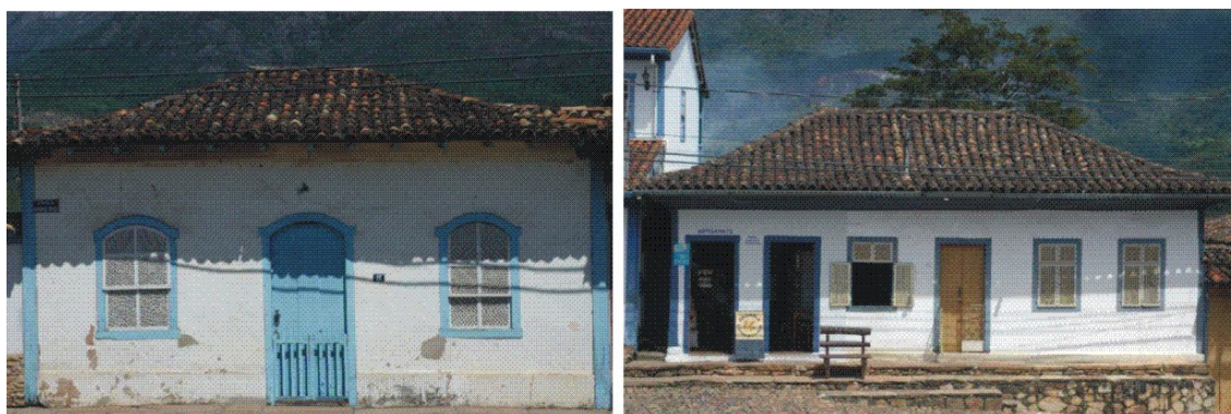
Figura 20: Registro fotográfico de fachadas das edificações
